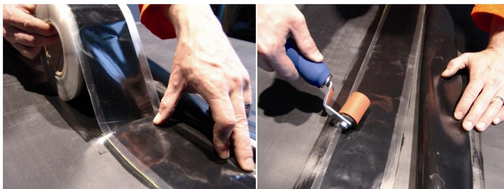
Laisser tomber le lé supérieur et vérifier l'alignement de la bande afin qu'elle reste visible lorsque le joint sera fermé. Enlever le polyéthylène de protection et pousser avec la main pour faire de contact :
