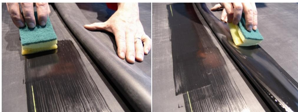
Vérifier le séchage du HP250 (toucher la surface avec la main et pousser la main vers l'avant pour vérifier le séchage) et appliquer la bande auto-adhésive Secur Tape, puis maroufler :
